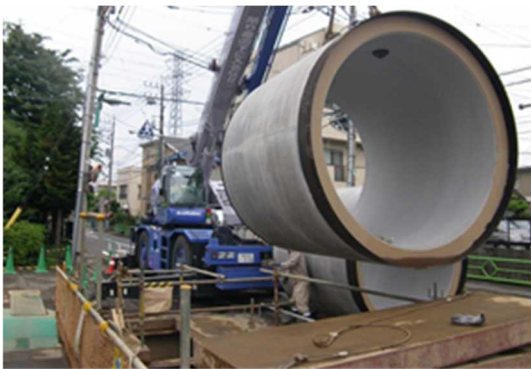
写真 3-1 雨水管きよの整備状況（中大口径）
