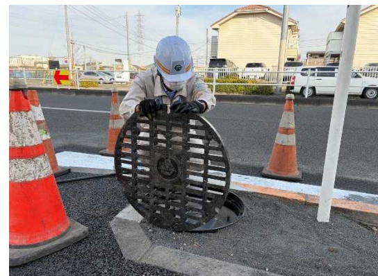
写真 3-4 圧力開放能力の高いマンホール蓋
