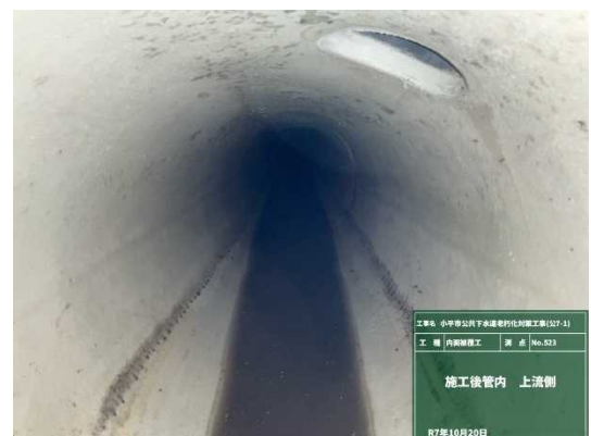
写真 3-7 更生工法による管きよ本体の改築の例
