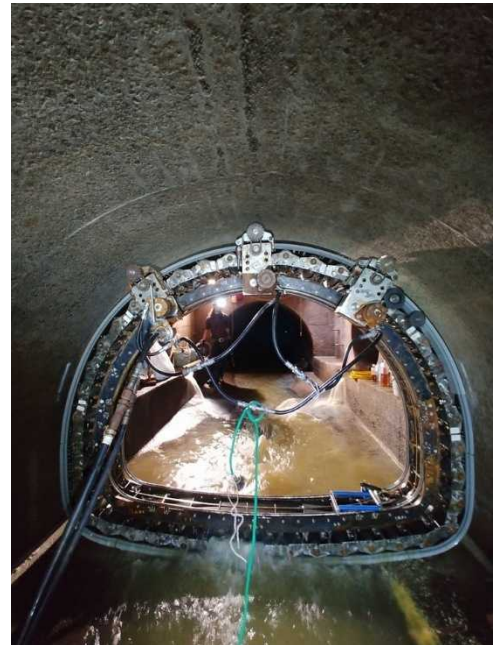
写真 3-5 耐震化工事の状況
