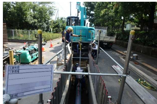
写真 3-2 雨水管きよの整備状況（小口径）
