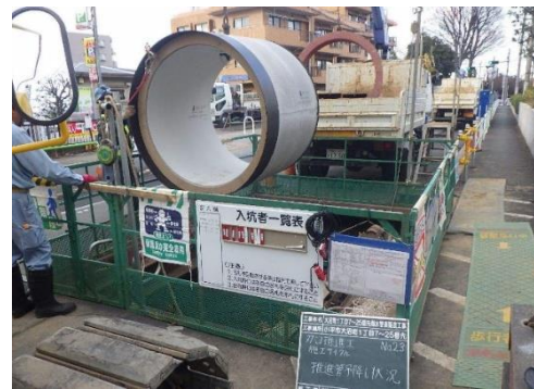
雨水管きよ整備
