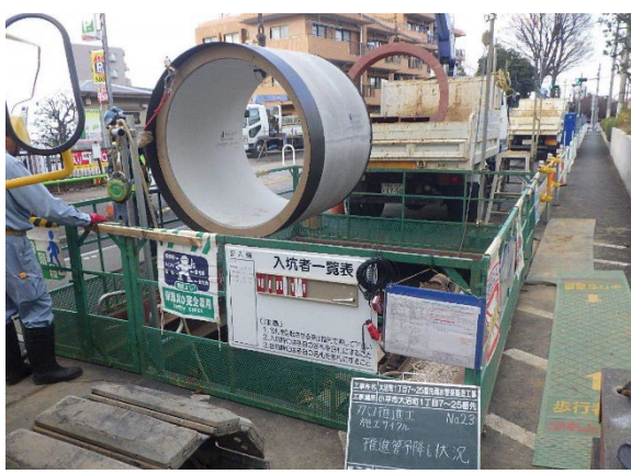
雨水管きょ整備
